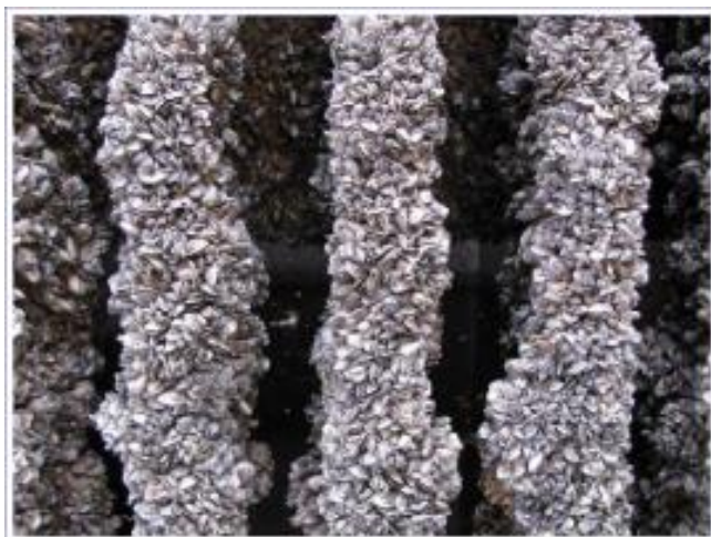
Figura 28. Rejas de basura infestadas de mejillón quagga. Tomado de Stephen, 2013.
