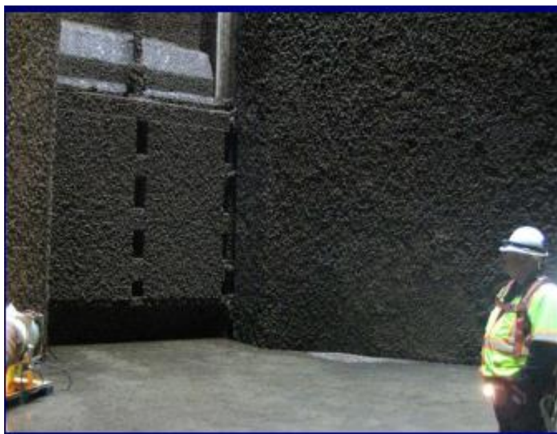
Figura 31. Acueductos del Río Colorado infestados de mejillón. Tomado de Stephen, 2013.
